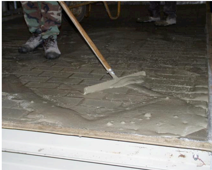
Abb. 3: Einbringen des Fugenmörtels
