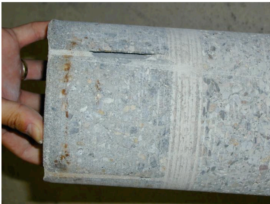
Abb. 9 a/b: Ansicht der Fugen nach Beendigung der Versuche (Pflaster auf Dränbetontragschicht)
