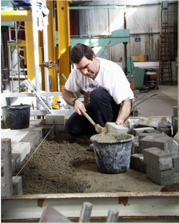
Abb. 2: Auftragen der Haftbrücke und Einbau des Pflasters
